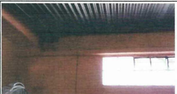
Foto 3: Se hará un mejoramiento de las ventanas del aula para mayor ventilación.
