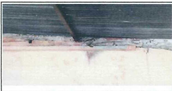
Foto 6: Se hará el mejoramiento de la terminación de la pared para hacer una nueva instalación de la cubierta y estructura de techo.
